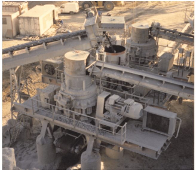
Anlage mit DUSTEX® im Einsatz
